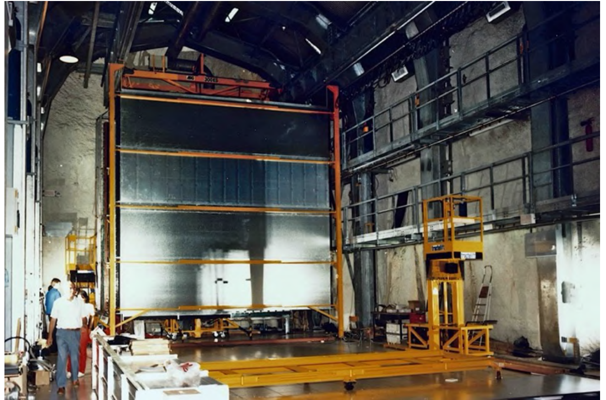
Assemblage du détecteur Cible = 200, puis 900 tonnes de fer
