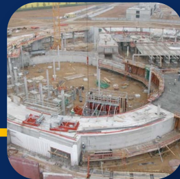
2002 Construction de SOLEIL
