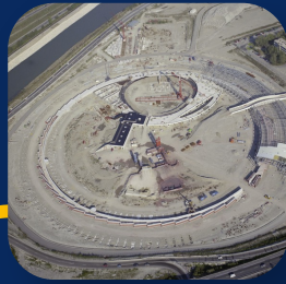
1990 Construction de l'ESRF
